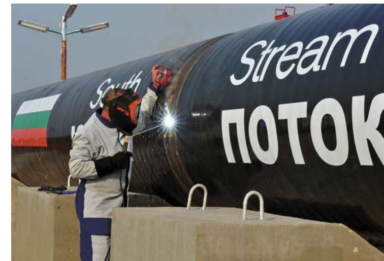
Строительство болгарского участка газопровода «Южный поток». © ОАО Газпром, 2014
